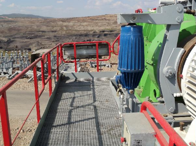
Монтаж приводной станции в КЕК KOSOVO – Обилич
