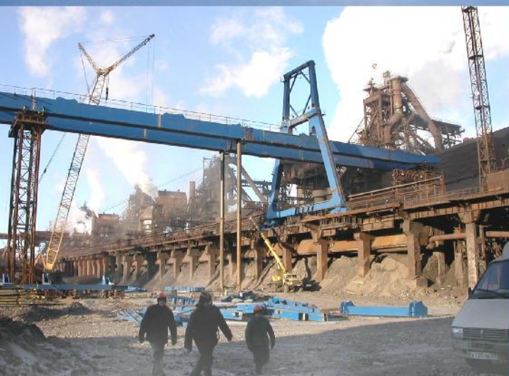
Сборка крана на Нижнетагильском металлургическом комбинате - Россия
